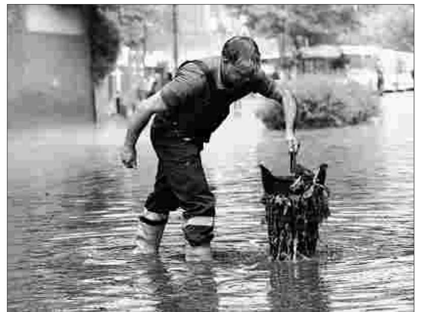
Unpassierbar: die Eisenbahnunterführung in Norddüren. Die Gullys waren von Treibgut verstopft.
